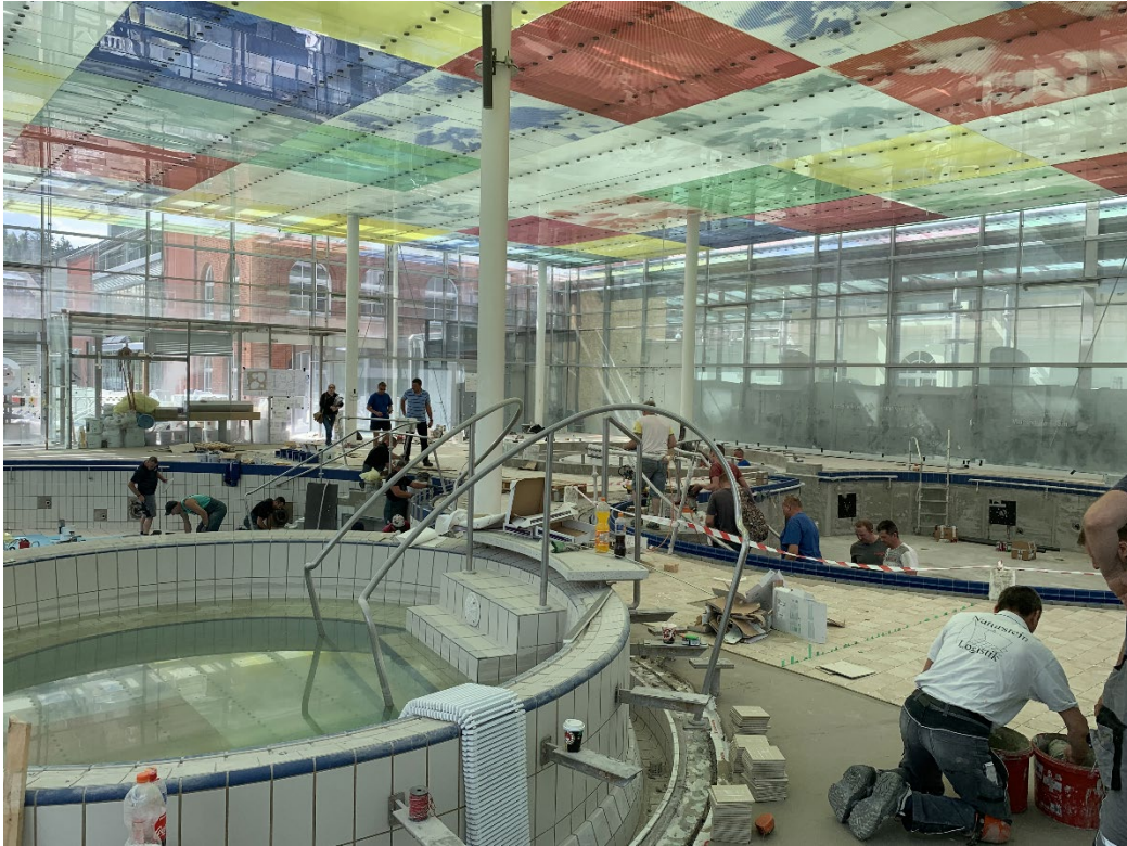
Die gesamte Badehalle inkl. Duschen wurde neu gefliest
