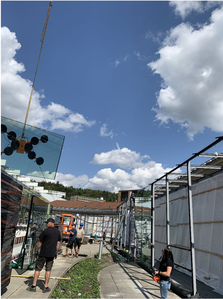
Neue Wärmeschutzverglasung der Glasgänge
